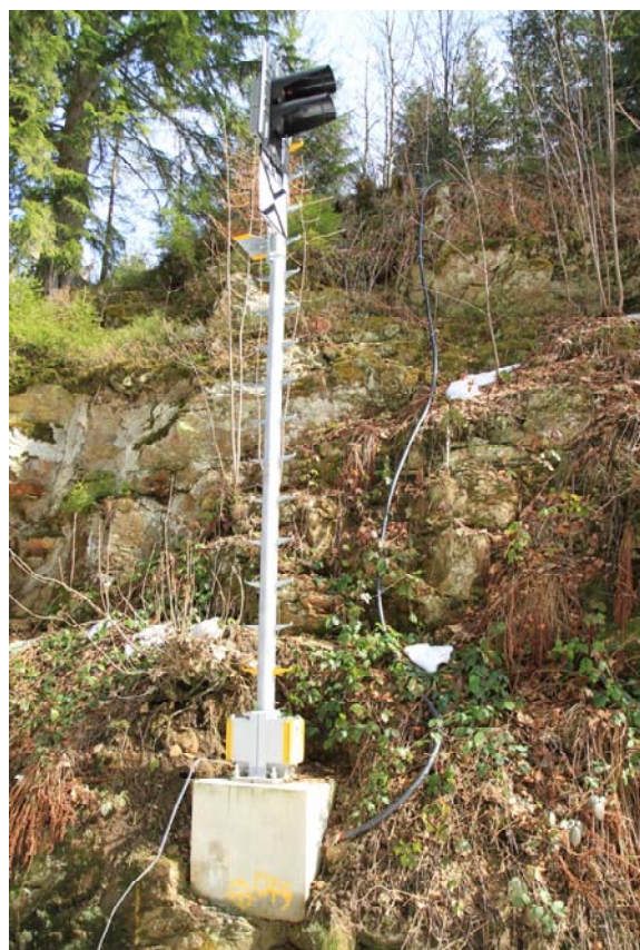
Obr. 15: Narušené partie masívu v km 6,000 s neznámým trubním vedením ve svahu
