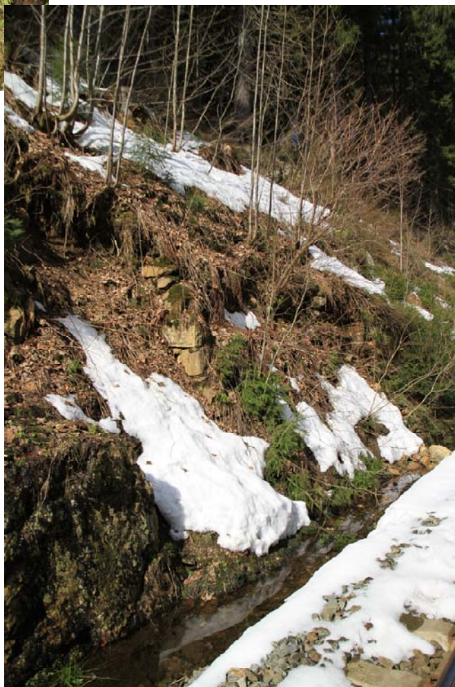
Obr. 14: Levostranný svah v km 5,990 navazující spodní partie svahu u vodoteče s relikty staré vyzdívky a silně zvětralým masívem
