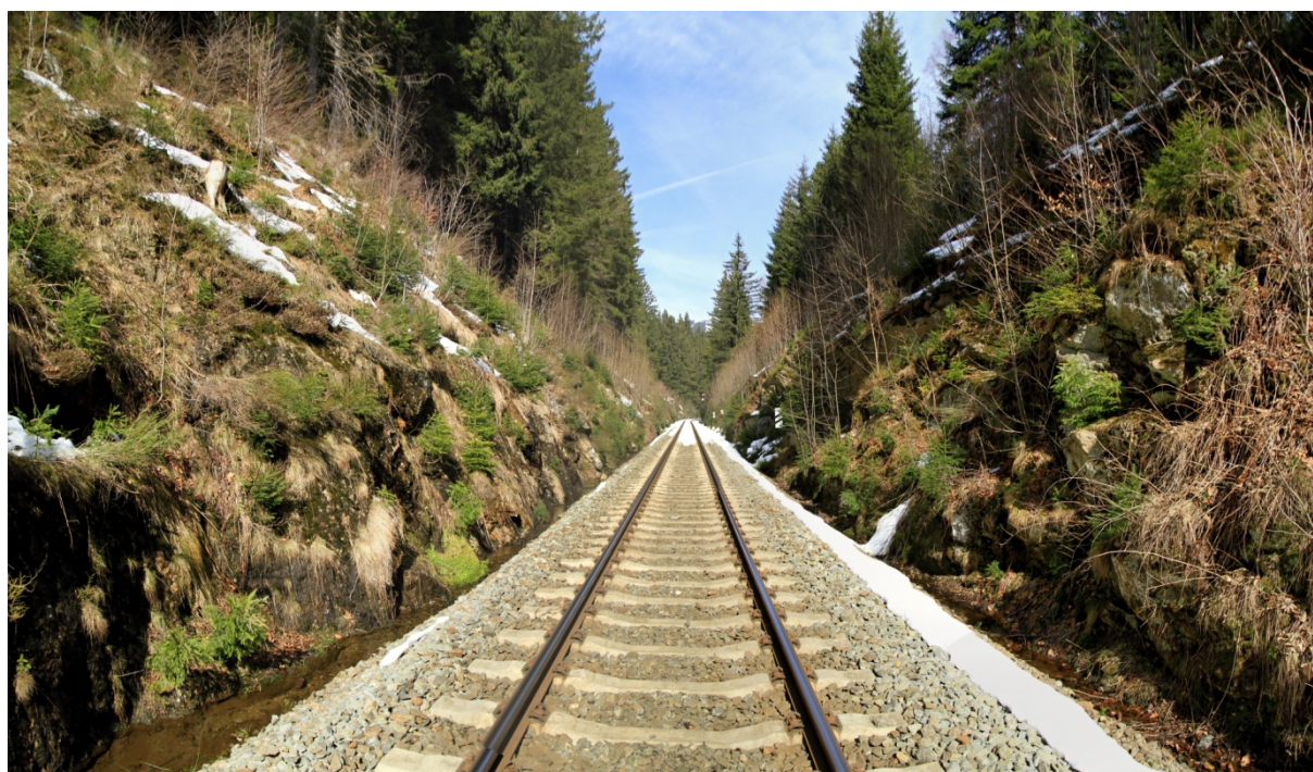
Obr. 12: celkový pohled na zářez v k 5,920 směr Klatovy, znatelný aktuální stav obou příkopů
