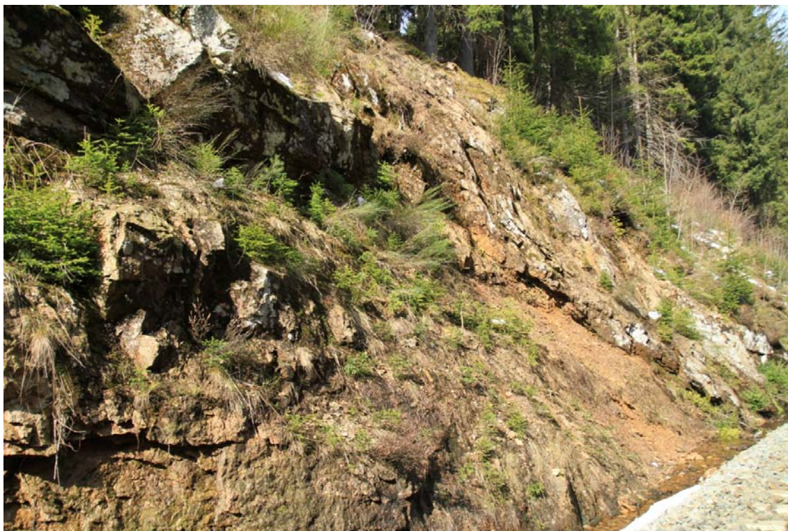
Obr. 11: Levostranný svah v km 5,900 se silně stabilitně narušenými partiemi
