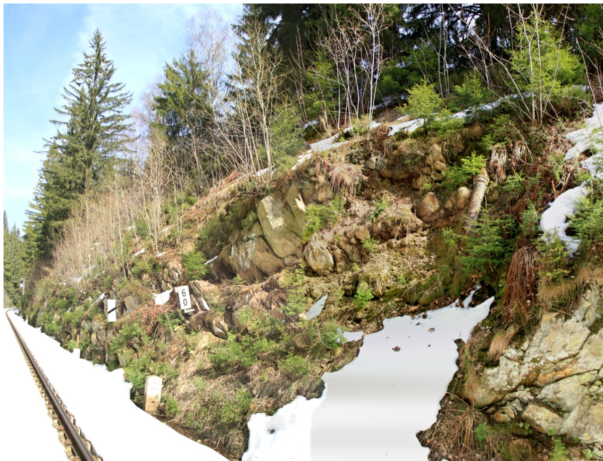
Obr. 15: Narušené partie masívu v km 6,000 s neznámým trubním vedením ve svahu
