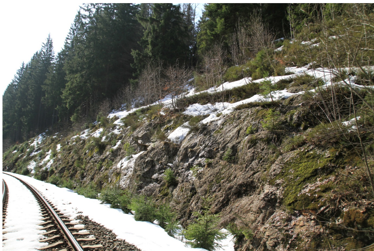
Obr. 19: Pohled na levostranný skalní masív v km 6,140 - 6,100, členitost masívu a vegetační kryt
