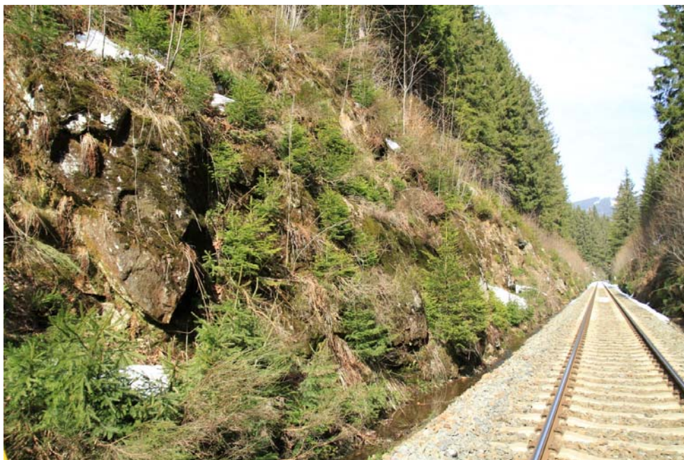
Obr. 7: Levostranný svah v km 5,850 s nestabilními pasážemi
